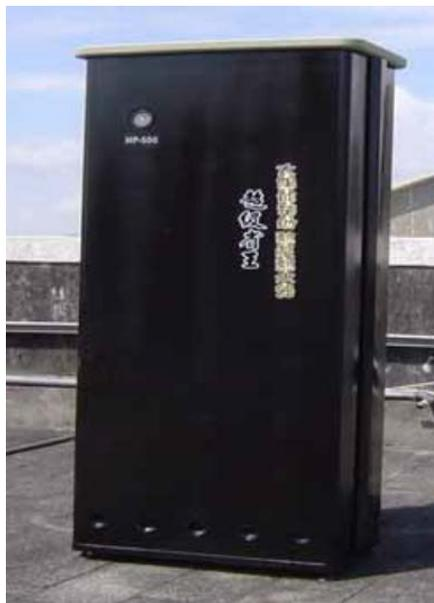
圖 3.2.2 太陽能輔助熱泵熱水器(ISAHP)<sup>8</sup>
