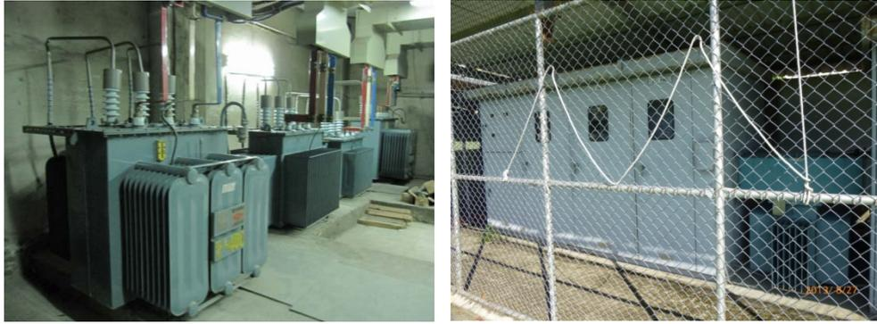
圖 4.2.1 常見的室內變電站(左圖)與室外變電站(右圖)設置
