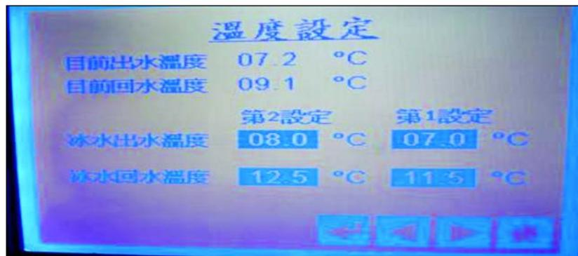
圖 2.3.2 冰水主機出水溫度設定畫面
