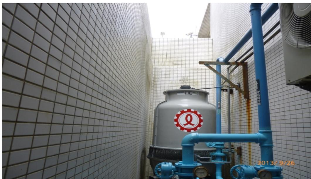
圖 2.3.7 冷卻水塔散熱不良
