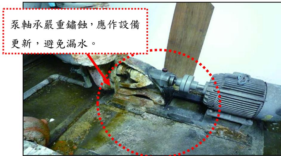
圖 2.3.3 水泵浦軸承鏽蝕漏水
