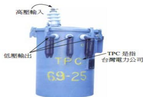
圖 4.1.3 變壓器示意圖
