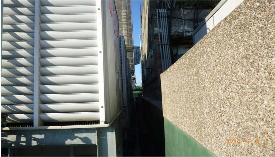
圖 2.3.8 冷卻水塔設置過於靠近牆面
