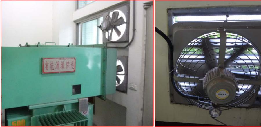
圖 4.2.4 高壓變電室設置排風扇並搭配溫控開關
