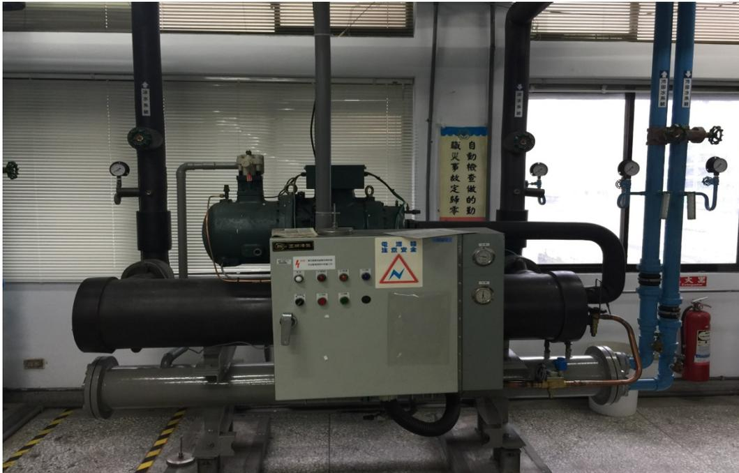
圖 2.1.12 中央空調冰水主機（螺旋式 40RT）
