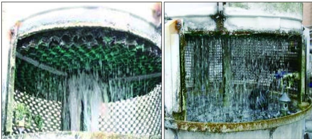
圖 2.3.9 冷卻水塔灑水不均(左圖)與正常情況(右圖)之對照
