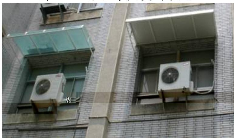
圖 2.3.13 正確的室外機安裝方式
