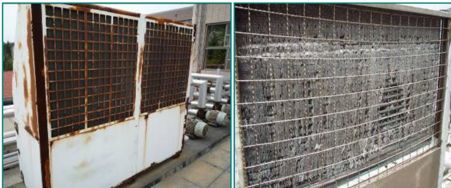
圖 2.3.10 設備外觀鏽蝕與鰭片破損情形
