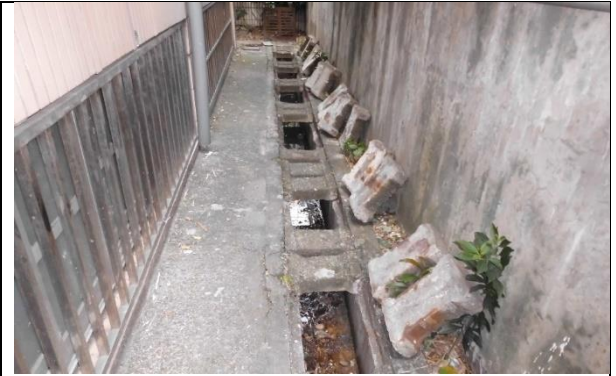
防汛期清理排水溝
